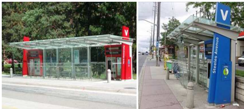
Рисунок 8 - Зупинки, устатковані захисними армованими півметровими стовпчиками, збільшеною висотою тротуару і захистом від брызг з-під коліс проходить повз транспорту - оснащений зупинний павільйон з заскляними перегородками
