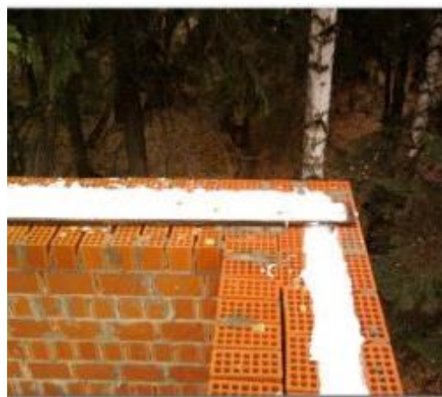
Рисунок 1 - Утепление кирпичной стены способом заливки пеноизола "ЮНИПОР" в зазор кладки.
