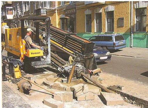
Рис.1. Установка направленного бурения фирмы «Wermeer» (США).
